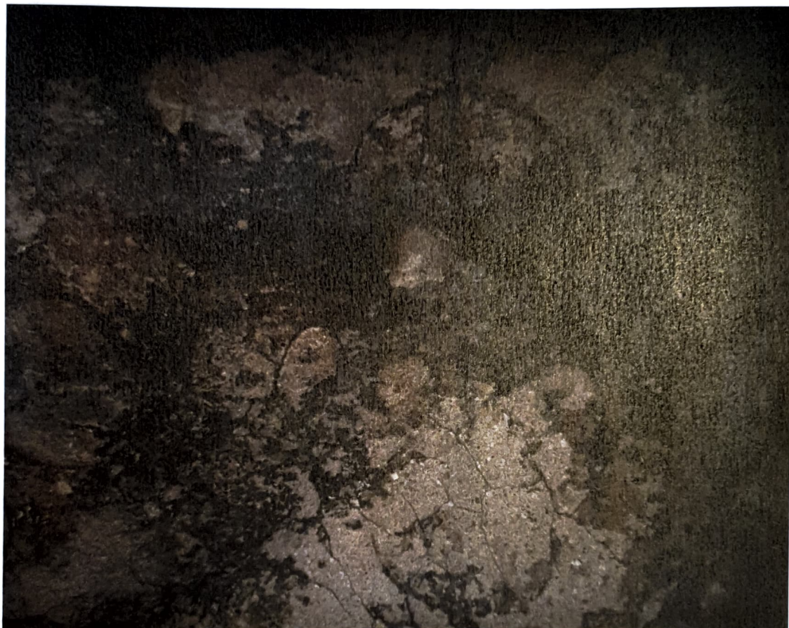
Fot. 3. Toruń, kościół WNMP, 1 kondygnacja, pomiędzy wieżyczką środkową a południową, dekoracja nad oknem, przed pracami konserwatorskimi w 2018 r.
