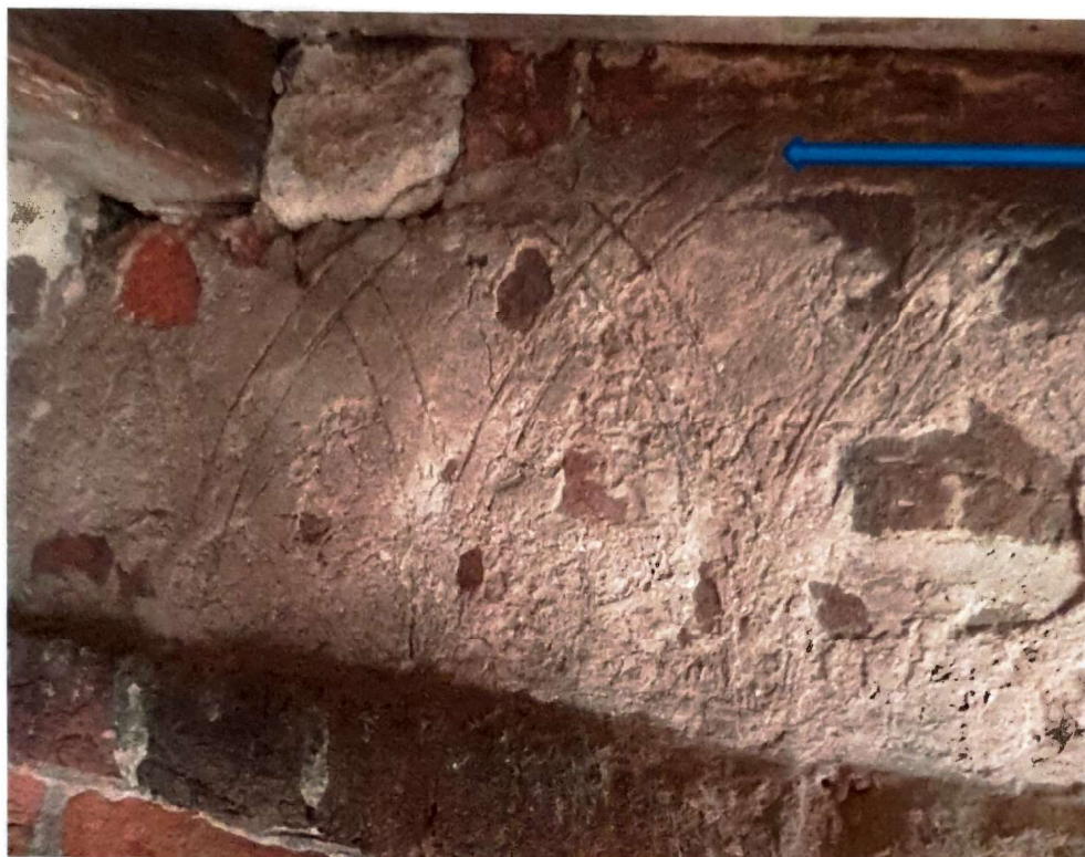
Fot. 5. Toruń, kościół WNMP, zakrystia, fryz wschodni, stan przed konserwacją 2020 r.
