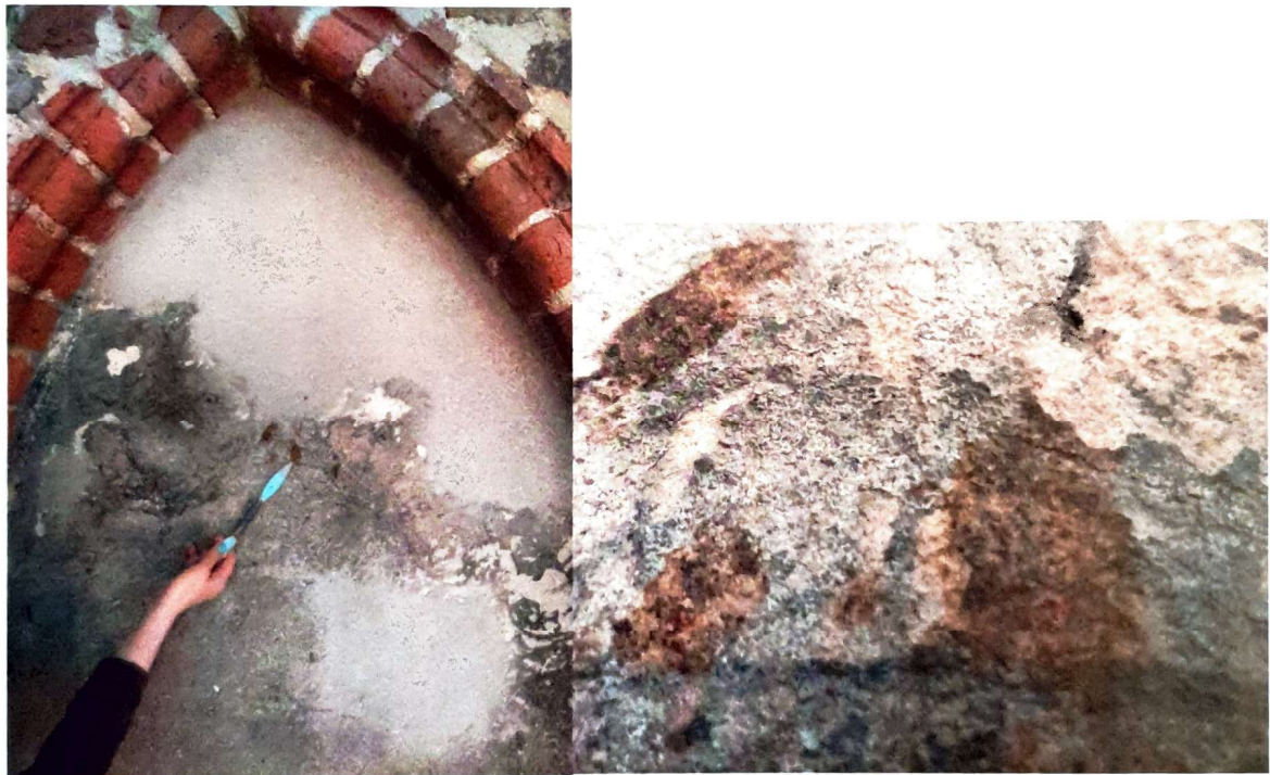
Fot. 12. Toruń, kościół WNMP, zakrystia, szczyt wschodni, blenda po stronie południowej, miejsca występowania czerwieni w tle dekoracji maswerkowej
