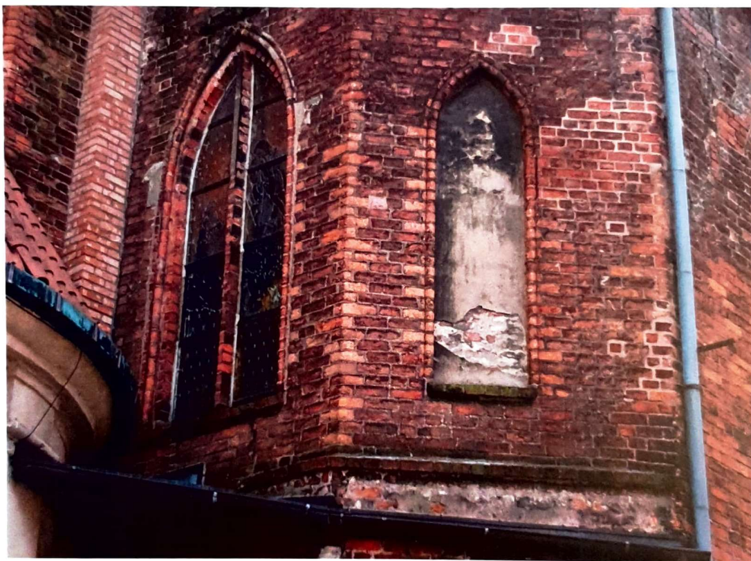
Fot. 1. Toruń, kościół WNMP, zakrystia, strona północnwschodnia, blenda oraz tynkowany fryz, przed pracami konserwatorskimi w 2018 r.
