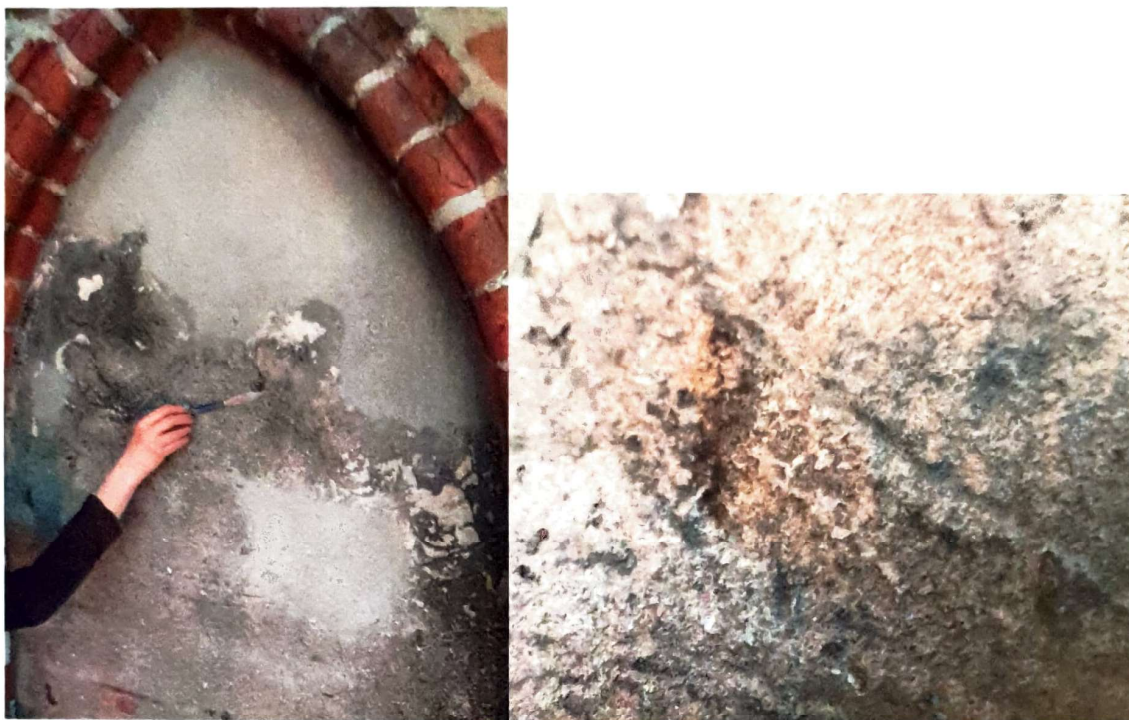
Fot. 13. Toruń, kościół WNMP, zakrystia, szczyt wschodni, blenda po stronie południowej, miejsca występowania pobiaty na laskowaniach dekoracji maswerkowej
