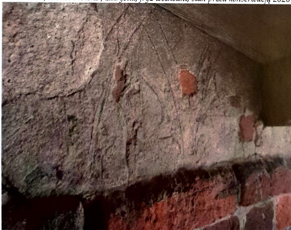
Fot. 6. Toruń, kościół WNMP, zakrystia, fryz wschodni, stan przed konserwacją 2020 r.
