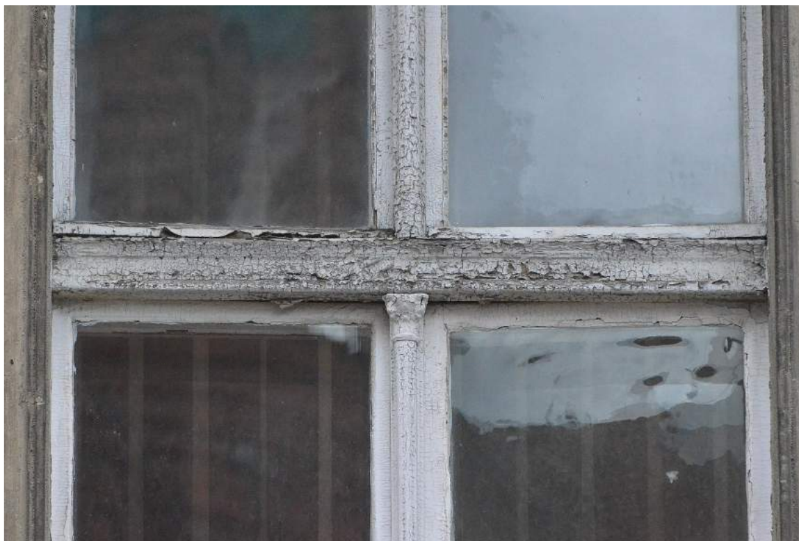
II. 7 Toruń, Kamienica przy ul. Rynek Staromiejski 18 - pierwotna stolarka okienna – widok na fragment krzyża okiennego, z przechodzącym ślemieniem
