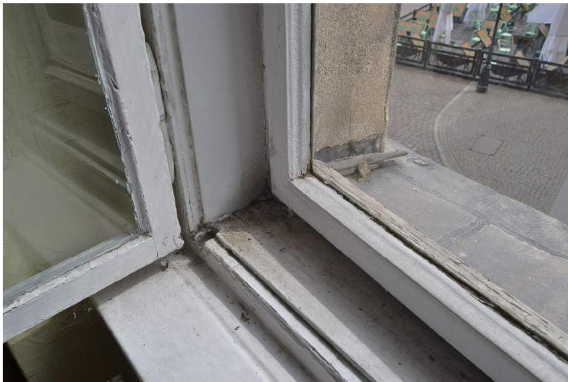
II. 8 Toruń, Kamienica przy ul. Rynek Staromiejski 18 - pierwotna stolarka okienna – widok na próg skrzynki i parapety
