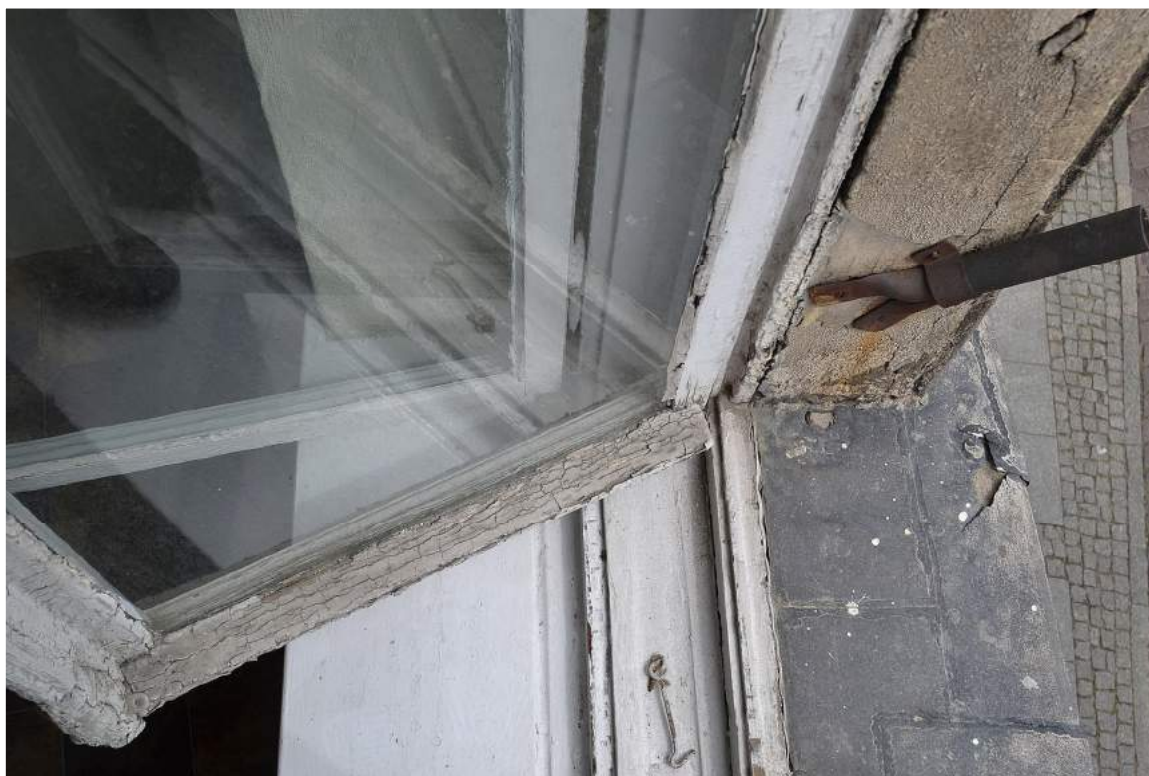
II. 9 Toruń, Kamienica przy ul. Rynek Staromiejski 18 - pierwotna stolarka okienna – widok na próg i fragment stojaków skrzynki oraz parapety
