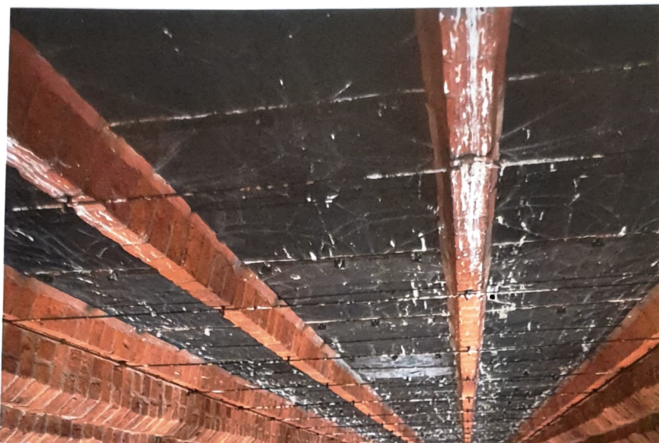
Fot. 5. Fragment okna z widocznymi oderwanymi wiatrownicami i wybrzuszeniami kwater do wnętrza kościoła.
