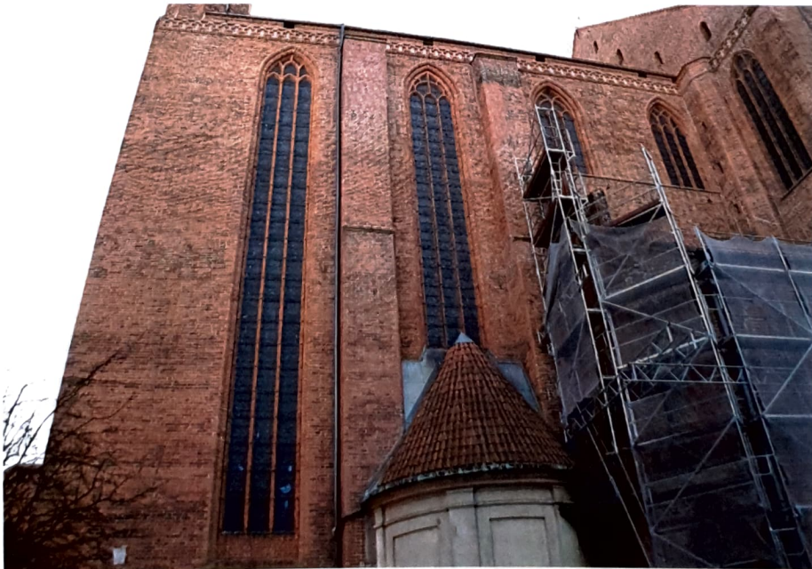
Fot. 2. Okna północne nr: nII, nIII, nIV, nV.
